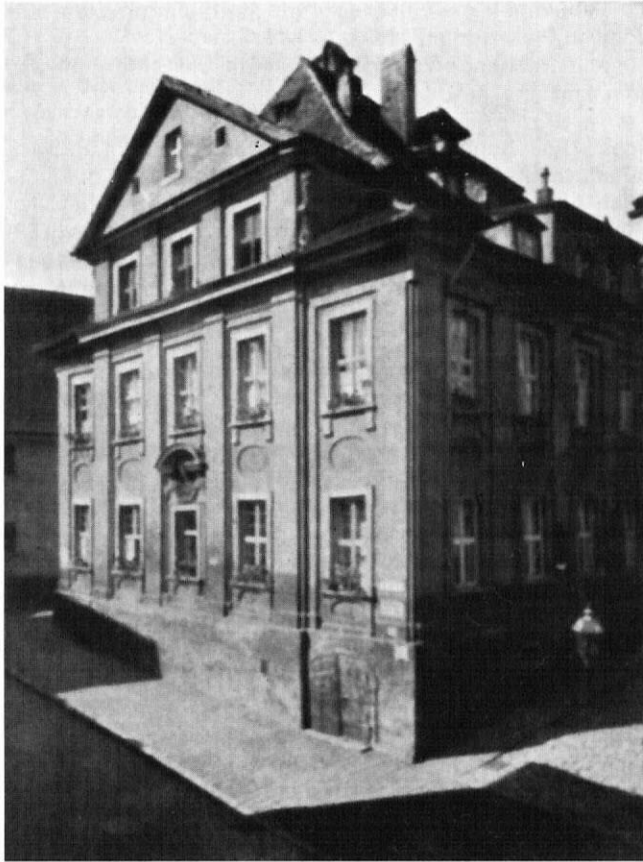
Das erste eigene Heim Im Hause Platen-Straße 18, das Gabrieli Anfang des 18. Jahrhunderts erbaute, findet die Gewerbe- und Landwirtschaftsschule von 1833 bis 1849 ein erstes Domizil.
