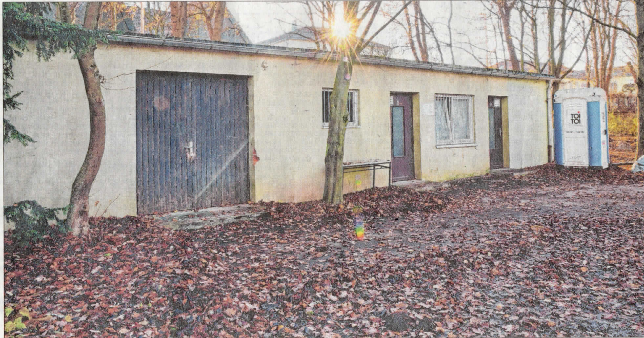
Container sollen den Bestand im Hofgarten ersetzen. Um das Ganze aufzuhübschen, ist vorgesehen, standorttypische Gehölze rund um die neue Anlage zu pflanzen. Foto: Jim Albright
