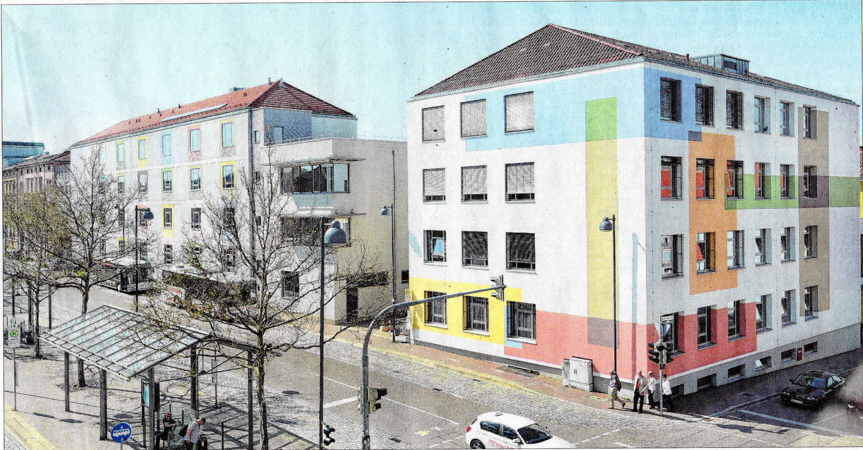
Als Beispiel im Bauausschuss nannte Dr. Frank Simons unter anderem den C-Bau des Platen-Gymnasiums (linkes Gebäude). Da es keinen funktionierenden ersten Rettungsweg gibt und keinen erreichbaren zweiten, ist als Sofortmaßnahme eine Gerüsttreppe geplant. Archivfoto: Jim Albright
