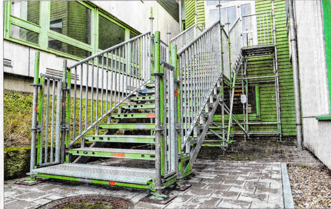
Eine der drei Brandschutztreppen, die am Gebäude des Theresien-Gymnasiums bereits fertiggestellt sind. Die vierte konnte wegen der fehlenden Prüfstatik noch nicht aufgebaut werden. Foto: Tizian Gerbing
