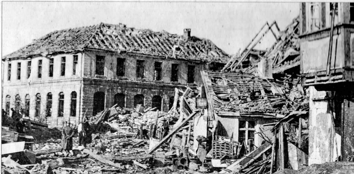
Dieses Bild zeigt die Verwüstungen im Bereich des Bahnhofsplatzes und der heutigen Bischof-Meiser-Straße. Auch die Oberrealschule wurde teilweise zerstört. Foto: FLZ-Archiv/Ernst GÜth
